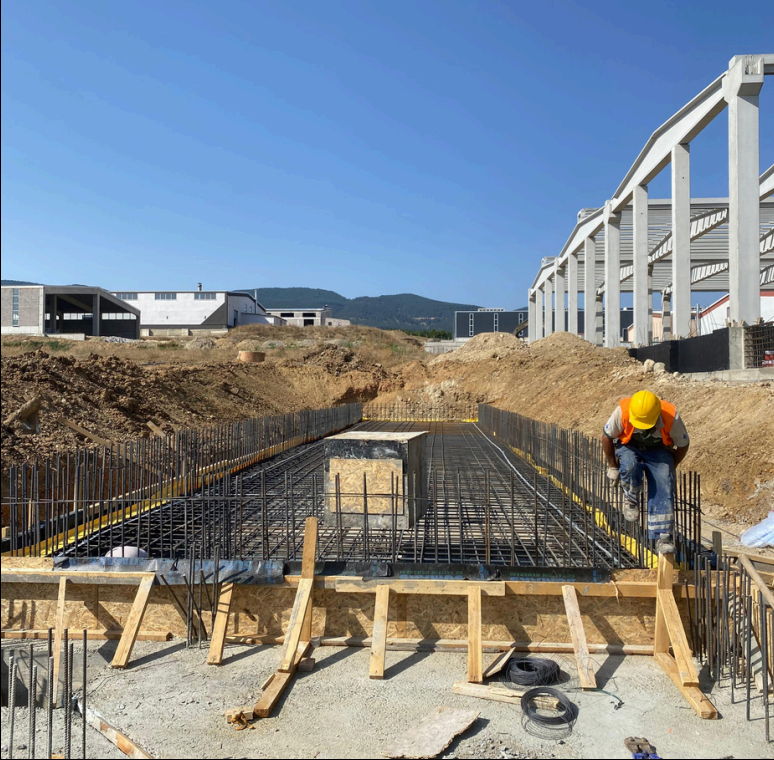
KABA İNŞAAT TEMEL İMALATLARI
